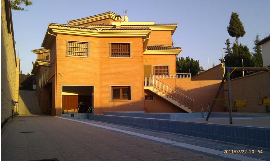
Vista noroeste de la vivienda. Primer plano en bajo: piscina de nado. Fondo derecha: piscina de juegos, acceso a planta 0, transición a terraza sur y portalón para aparcamiento exterior de 4 a 6 vehículos. Fondo izquierda: rampa norte para acceso a nivel calle Mistral con puerta basculante automática para vehículo. Medio centro: cara oeste de planta -1 (zaguán intermedio para piscina de nado) y planta 0 (despachos dormitorios de ala oeste). Perímetro: muro en fábrica de bloque color terrano (Bloques Granada ®), en doble cara decorativa.
